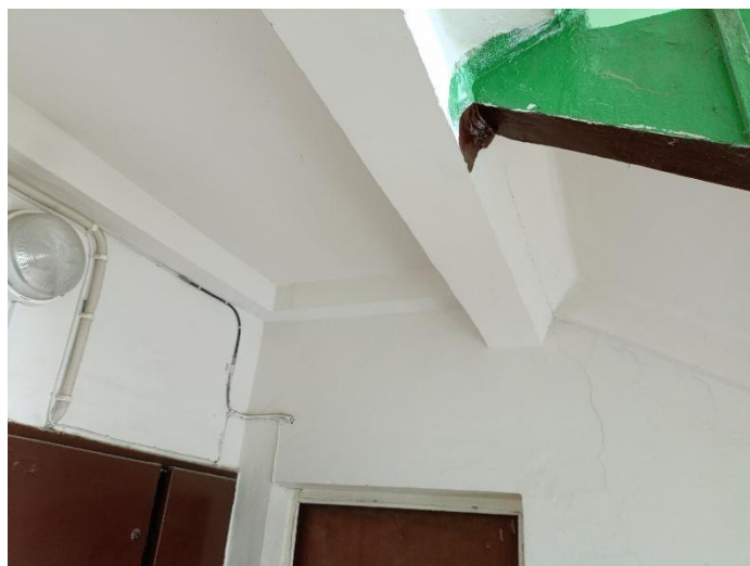
4.2.1. att. Plaisa kāpņu telpā. Līdzīgas plaisas ir visās 4 kāpņu telpā gandrīz visas ēkas augstuma. Plaisas ir līdz 4 mm biezumā. Nav caurejošas.
