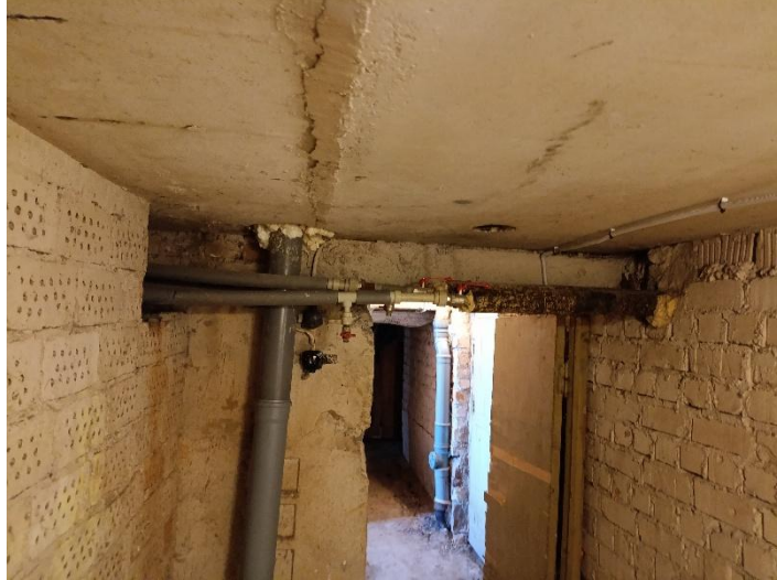
5.1.1. att. Fragmentāli nomainītas kanalizācijas caurule un ūdensapgādes caurules. Neatbilstoši izdarīta aizdare pārsegumā
