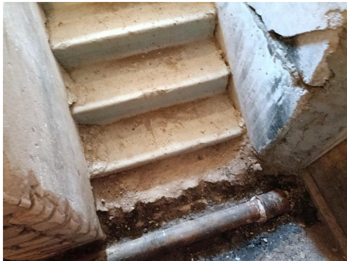
5.1.2. att. Esoša lietussūdens kanalizācijas caurule ar stipro koroziju.
