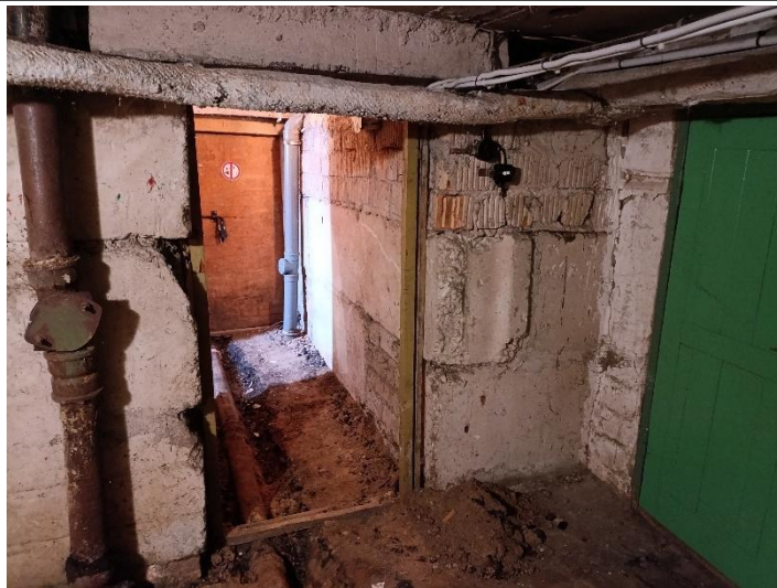
5.1.3. att. Esošas kanalizācijas caurules ar stipro koroziju. Ūdensapgādes caurules vecā azbestcimenta siltumizolācijā.
