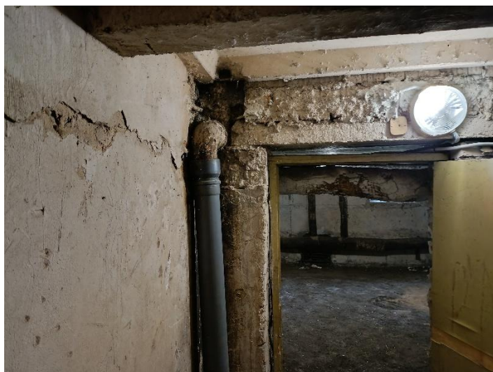
5.1.4. att. Nomainīta kanalizācijas caurule uz PVC, bet tomēr pieslēgta pie esošas nemainītas esošas vecas tērauda caurules ar stipro koroziju
