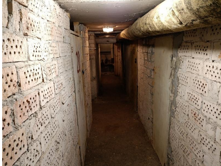
5.4.1. att. Esošās apkures sistēmas cauruļvadu azbestcements izolācija. Nav informācijas par viņas energoefektivitāti. Siltumizolācija nav draudzīga apkārtējai videi, neatbilst BL 9.panta p.3.
